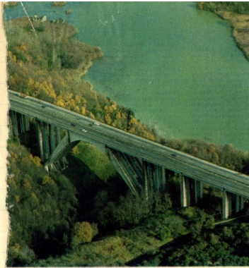
Il viadotto San Giuliano sull'Autostrada del Sole.
