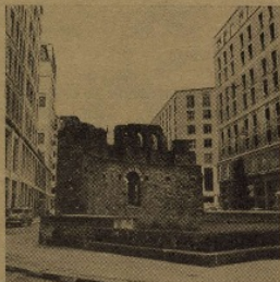
Milano. Il rudere inventato. Gli sventramenti in un centro storico e la sua ricostruzione intensiva portano a mostruosità come questa, alla creazione di monumenti artificiali. Questo è quanto resta della chiesa romanico-gotica di San Giovanni in Conca in piazza Altieri distrutta per « ragioni di traffico », e ridotta ad isola puritana sotto, come un gabinetto pubblico, una delle più belle cripte di Lombardia. *
