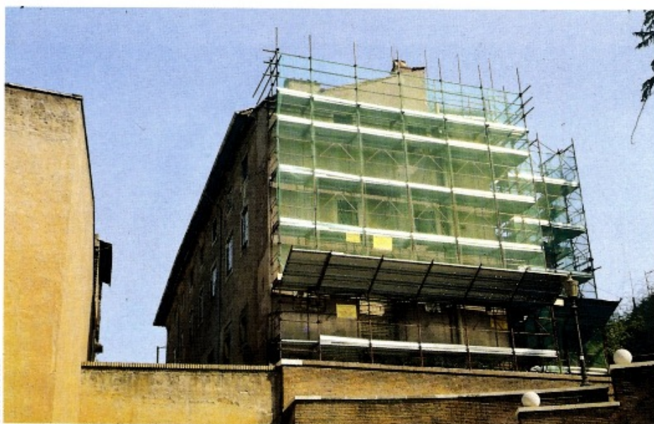
Palazzo Rivaldi coperto da ponteggi per lavori «misteriosi e clandestini»: dovrebbe essere destinato a museo, ma c'è il sospetto che l'edificio possa essere trasformato in albergo. Manca un cartello esplicativo dei lavori in esecuzione e che, invece, è prescritto dalla legge
