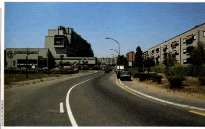
Il «serpentone» della zona di Salaria e, in alto, il palazzo-mostro di Corviale, due costruzioni emblematiche della speculazione edilizia nelle periferie di Roma
