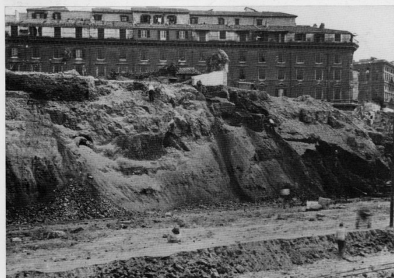
Figg. 88-90 — I "vecchi calcestruzzi romani" in corso di demolizione lungo via del Colosseo.
