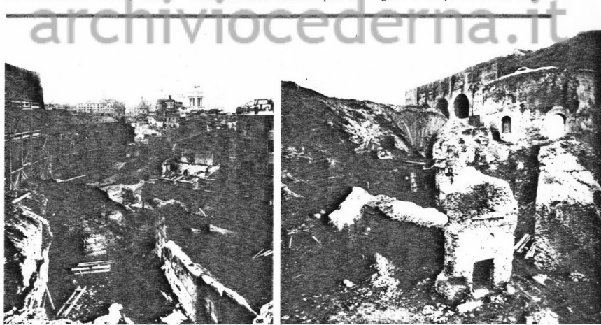
L'apertura di via dei Fori Imperiali vista dall'alto della Velia in direzione del Monumento a Vittorio Emanuele. In primo piano gli edifici antichi che si vanno demolendo: la vasta arteria tracciata con l'intenzione di esaltare la romanità con un percorso che ne attraversa i resti più significativi, si è in realtà fagocitata una buona fetta dell'antica storia di Roma.
