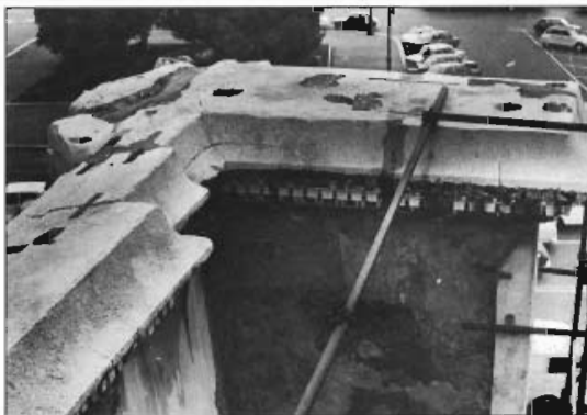
Plan supérieur de l'attique de la colonnade avec les trous pour les tenons des statues en bronze.
