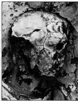
L'œuvre du temps sur la colonne Trajan : les têtes de deux personnages, photographiées en 1982, réduites à une masse informe où l'on ne distingue plus les détails de la sculpture.
