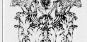
Les chapiteaux, fastueux dans leur richesse ornementale. Sont corinthiens : des touffes denses de laurier, au lieu de feuilles d'acanthus classiques, sortent des caules et sont disposées sous les volutes du chapiteau. Photo Barbara Malter.
