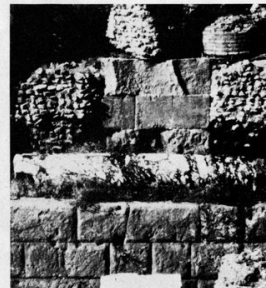
Le podium du temple d'Apollon formé par une structure en blocs de tuf de l'Aniene associés à du travertin et remplie de terre.
