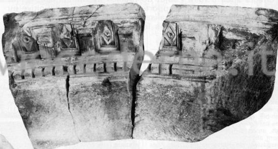
Petite console à courbure peu accentuée des édicules, sans décor sauf pour les caissons qui présentent ici une succession de losanges à rosace centrale.
