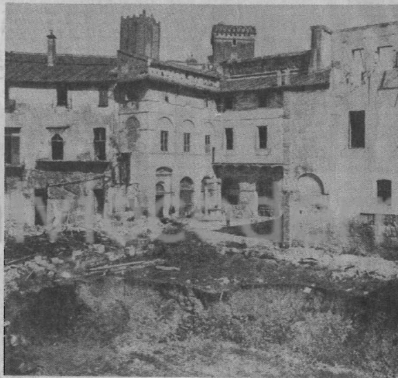
La demolizione del monastero dell'Annunziata (1924)
