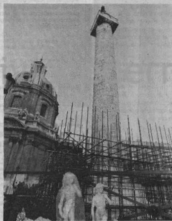
Lavori bloccati da un anno alla Colonna Traiana
