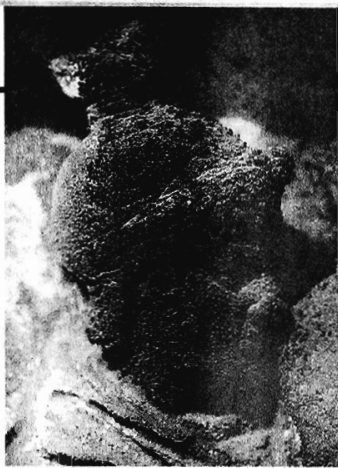
La «lebbra» copre interamente la testa di questo guerriero della Colonna di Marco Aurelio. Si tratta di una crosta di alterazione della ruota integra originaria in solfato di calcio, cioè gesso. È un fenomeno allarmante che interessa gran parte dei monumenti di Roma.
