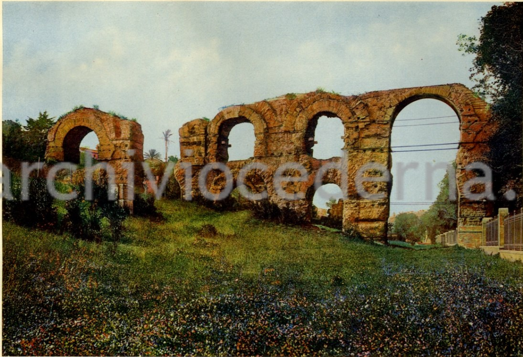
Fig. III. — Acquedotto neroniano al Palatino lungo la via di S. Gregorio.
