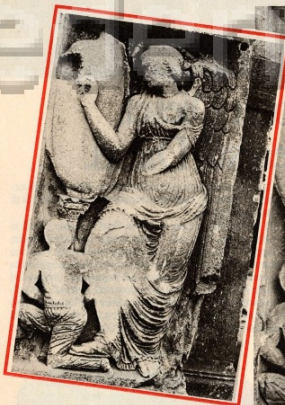
Vittoria alata dell'Arco di Costantino. In pochi decenni la testa si è trasformata in una spugna nera durissima, disintegrando la struttura del marmo.
