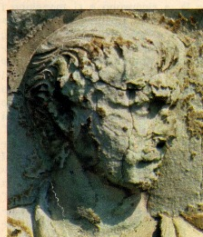
Qui sopra, a sinistra in alto e nella pagina accanto: particolari della Colonna Antonina. L'inquinamento atmosferico, combinandosi con l'umidità e le impurità dell'aria, devasta il marmo e lo trasforma in gesso. A sinistra in basso: sulla Colonna Traiana si sta sfaldando la testa dell'imperatore. Le foto di questo servizio sono state eseguite per conto della Soprintendenza archeologica di Roma.
