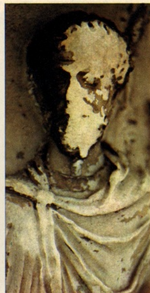
Qui sopra: la testa di Marco Aurelio; a sinistra in alto e in basso: altri particolari della Colonna Antonina. Le reazioni chimiche causate dall'inquinamento formano croste nere, che poi cadono e rivelano il bianco del gesso. Sotto: un particolare della Colonna Traiana.
