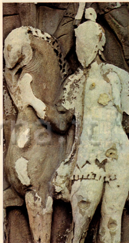
Qui sopra, a sinistra in alto e nella pagina accanto: particolari della Colonna Antonina. L'inquinamento atmosferico, combinandosi con l'umidità e le impurità dell'aria, devasta il marmo e lo trasforma in gesso. A sinistra in basso: sulla Colonna Traiana si sta sfaldando la testa dell'imperatore. Le foto di questo servizio sono state eseguite per conto della Soprintendenza archeologica di Roma.
