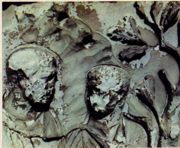
Qui sopra: la testa di Marco Aurelio; a sinistra in alto e in basso: altri particolari della Colonna Antonina. Le reazioni chimiche causate dall'inquinamento formano croste nere, che poi cadono e rivelano il bianco del gesso. Sotto: un particolare della Colonna Traiana.
