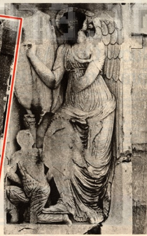
Vittoria alata dell'Arco di Costantino. In pochi decenni la testa si è trasformata in una spugna nera durissima, disintegrando la struttura del marmo.
