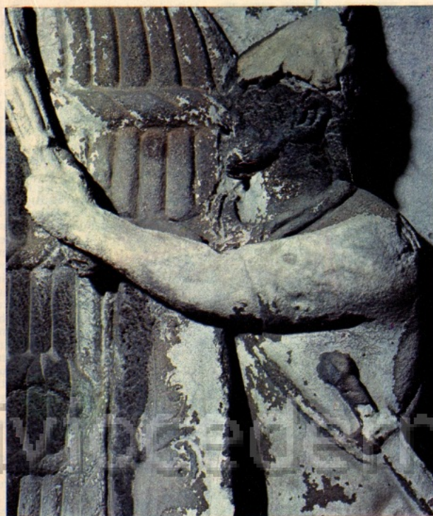
Qui sopra: la testa di Marco Aurelio; a sinistra in alto e in basso: altri particolari della Colonna Antonina. Le reazioni chimiche causate dall'inquinamento formano croste nere, che poi cadono e rivelano il bianco del gesso. Sotto: un particolare della Colonna Traiana.
