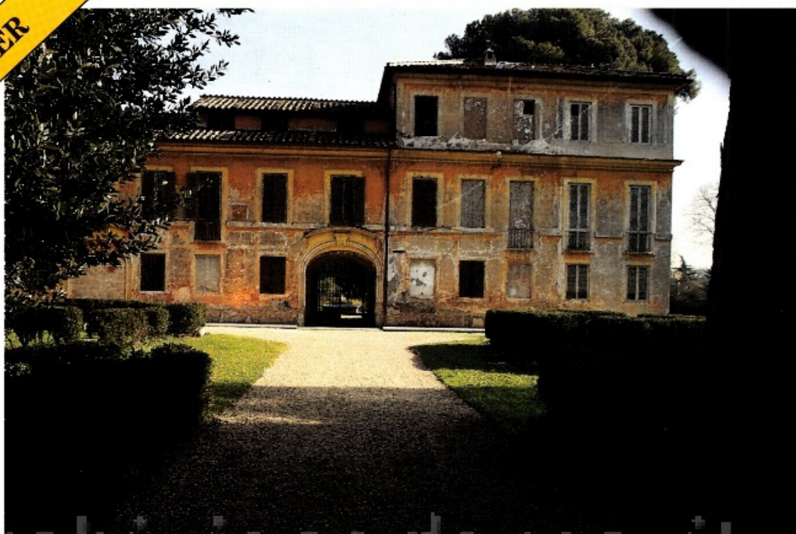
La palazzina del parco pubblico di Villa Chigi. A fronte, il laghetto di Villa Pamphili
