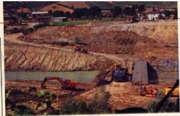
I lavori di costruzione della diga sul fiume Foglia, in località Peschiera di Tavullia, nel Pesarese.
