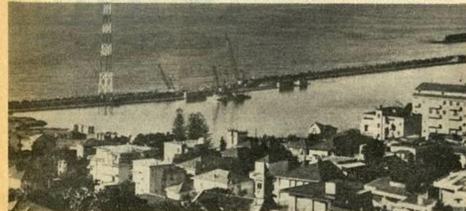
Una panoramica della diga dove dovrebbe sorgere il nuovo porto turistico di Sanremo (Telefoto Emmeti)
